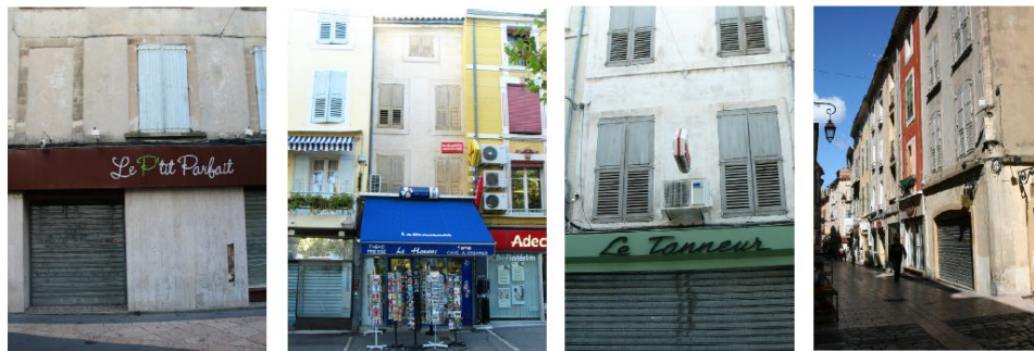
Rez de chaussée commerciaux et logements vacants rue des Marchands
