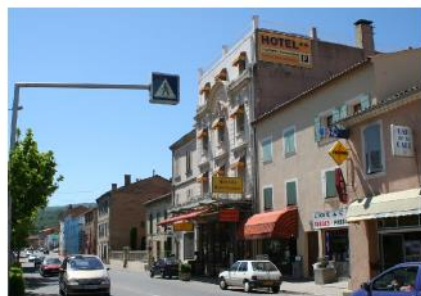
Façades hétérogènes, secteur Gare SNCF
