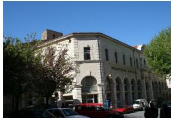
La Halle aux Grains, transformée à ce jour en bibliothèque, archives municipales
