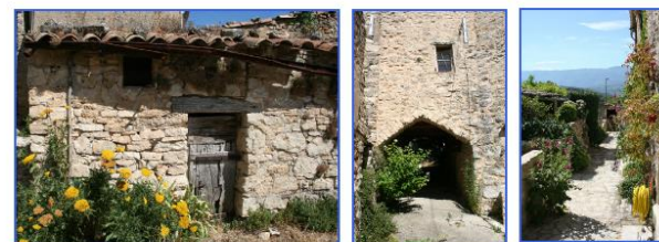
Remise en l'état, passage couvert et ruelle traitée en callade
