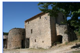
Habitat rural traditionnel en pierres, escalier extérieur, bergerie...
