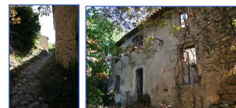
Ruelle étroite desservant le bas du hameau et ses jardins, maison en état de ruine...
