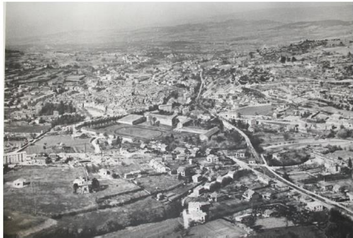
Vue aérienne 1960, depuis l'est sur le quartier de la Madeleine, le collège-en projet-, le cours Lauze de Perret
