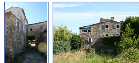
Chemin rural longeant les terrasses depuis la RD, ruelles étroites, porches, ambiances végétales fortes...
