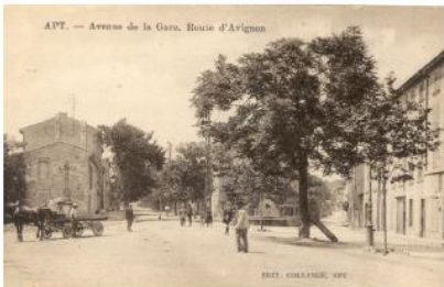
Avenue de la gare (route d'Avignon)
