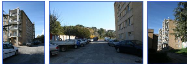
Un ensemble de logements en cours de réhabilitation, à une échelle humaine Un parking restant à traiter (cheminements et parkings à séparer)
