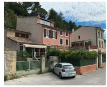
03. Construction existante Est
