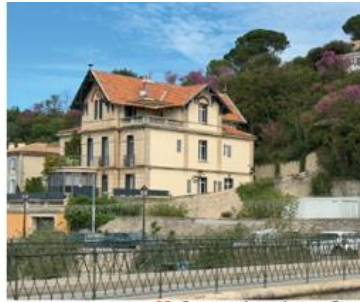
02. Construction existante Ouest
